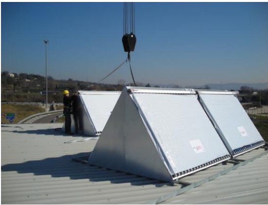
Montaggio su tetto con l'ausilio della gru.
